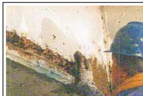
Colocación del bolo de Seal PLUG<sup>®</sup> en junta horizontal - Obra Estadio Boca Jrs.
